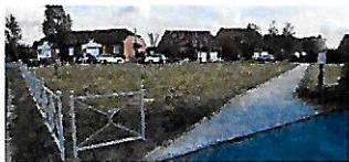
Pose d'une clôture
