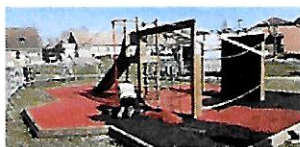
Pose d'un sol amortissant
