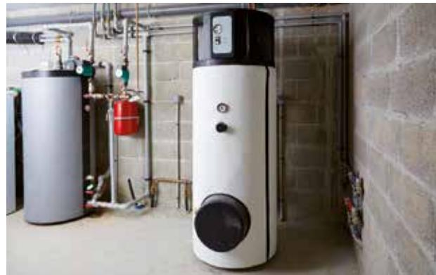
Chauffe-eau thermodynamique installé dans un sous-sol.
