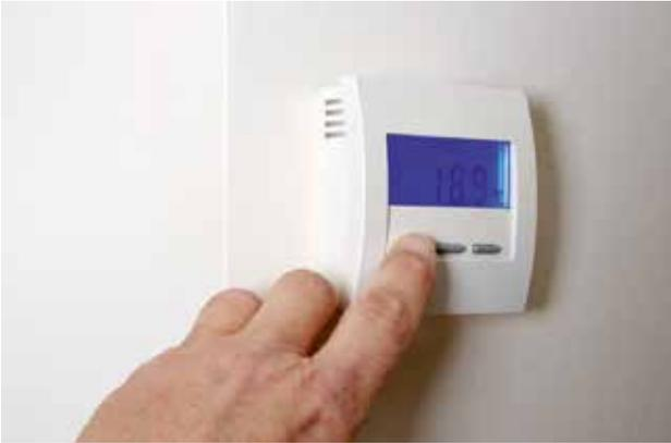
Une régulation et une programmation performantes optimisent le fonctionnement du chauffage et évitent les gaspillages. Vous pouvez ainsi réduire de 5 à 15% votre consommation d'énergie.
