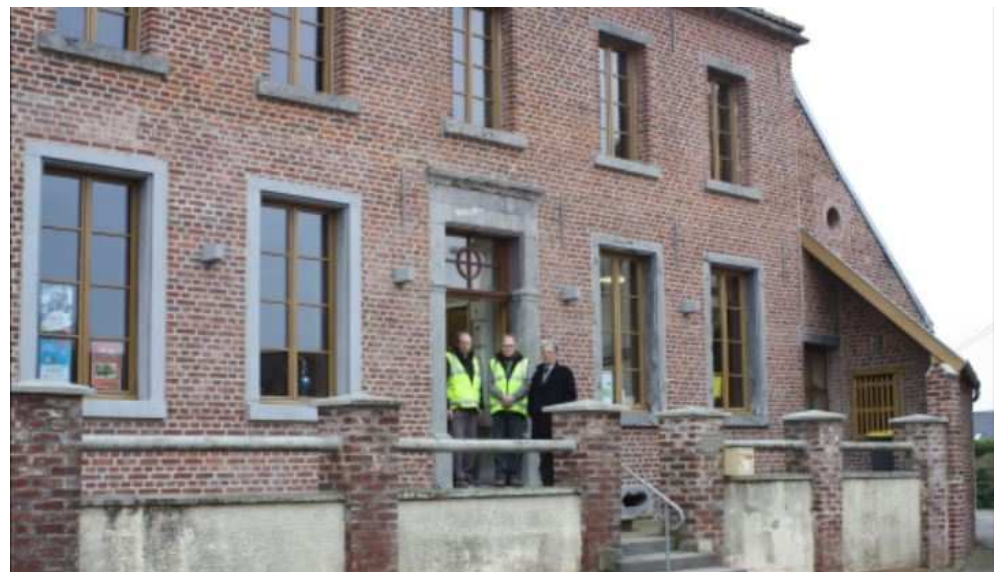
La façade de la mairie a été sablée et rejointoyée
