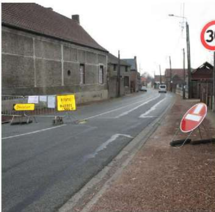
Une déviation a été mise en place dans les deux sens de circulation, à l'entrée et à la sortie de la commune.
